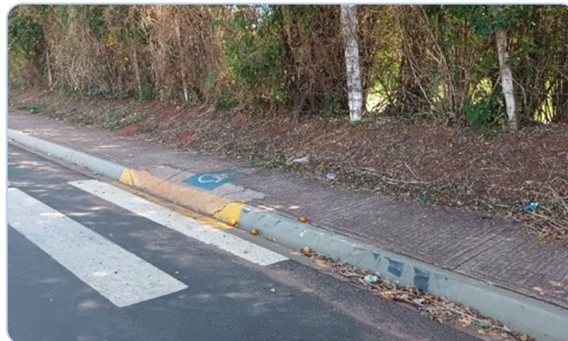
AI-01 - Necessidade de complementação dos rebaixamentos, conforme a NBR 9050
